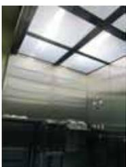
Pour améliorer le flux d'air descendant, des écrans PLF peuvent être incorporés avec un éclairage IP 65 placé au-dessus des écrans offrant ainsi un éclairage uniforme amélioré et un flux laminaire descendant complet.
